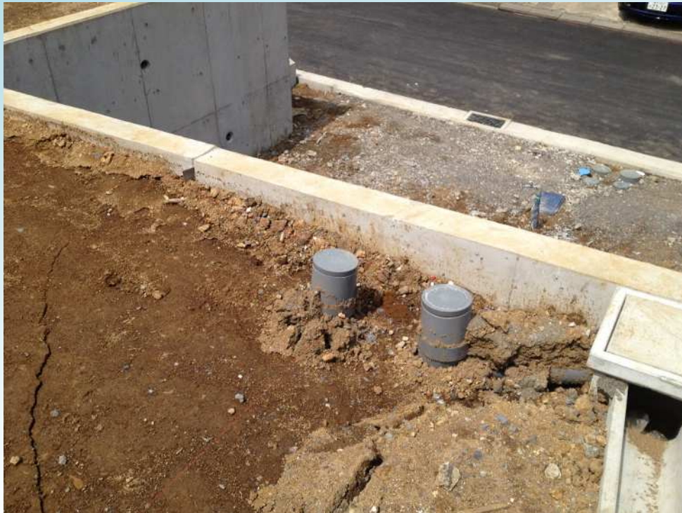
(a) 擁壁埋め戻し部
