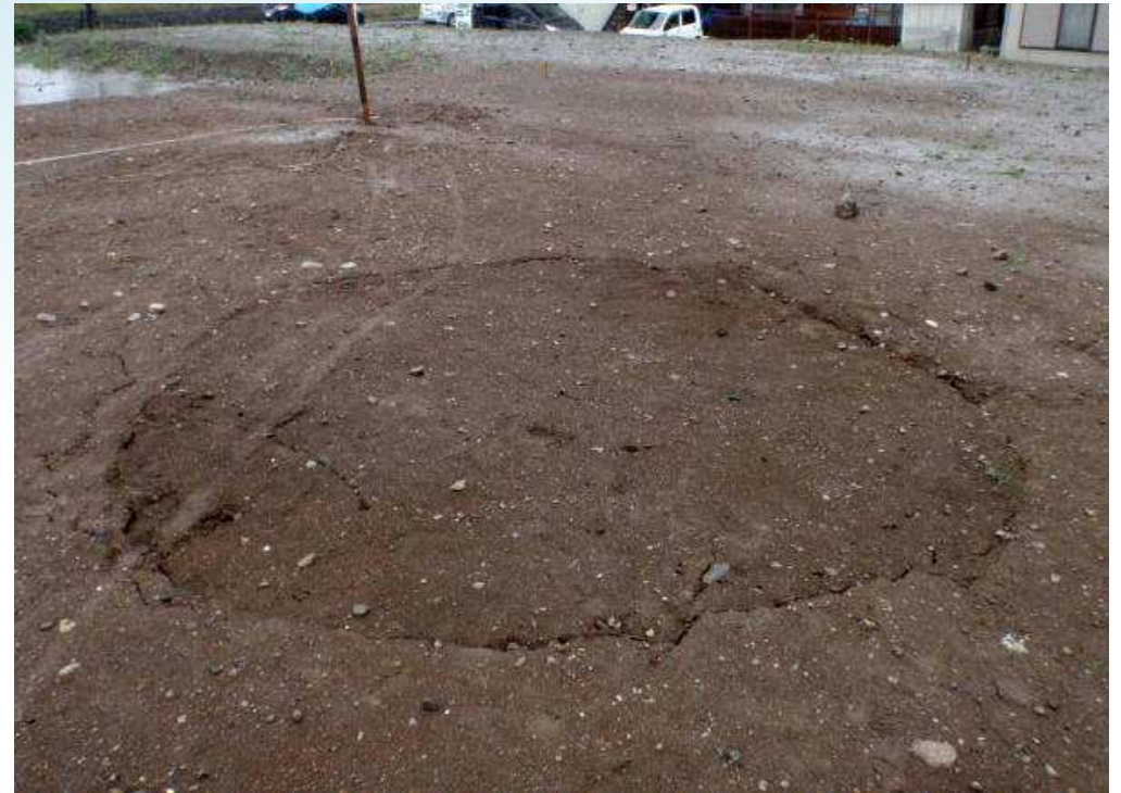
(b) 樹木抜根埋め戻し部
