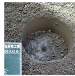
杭頭レベル調整後
