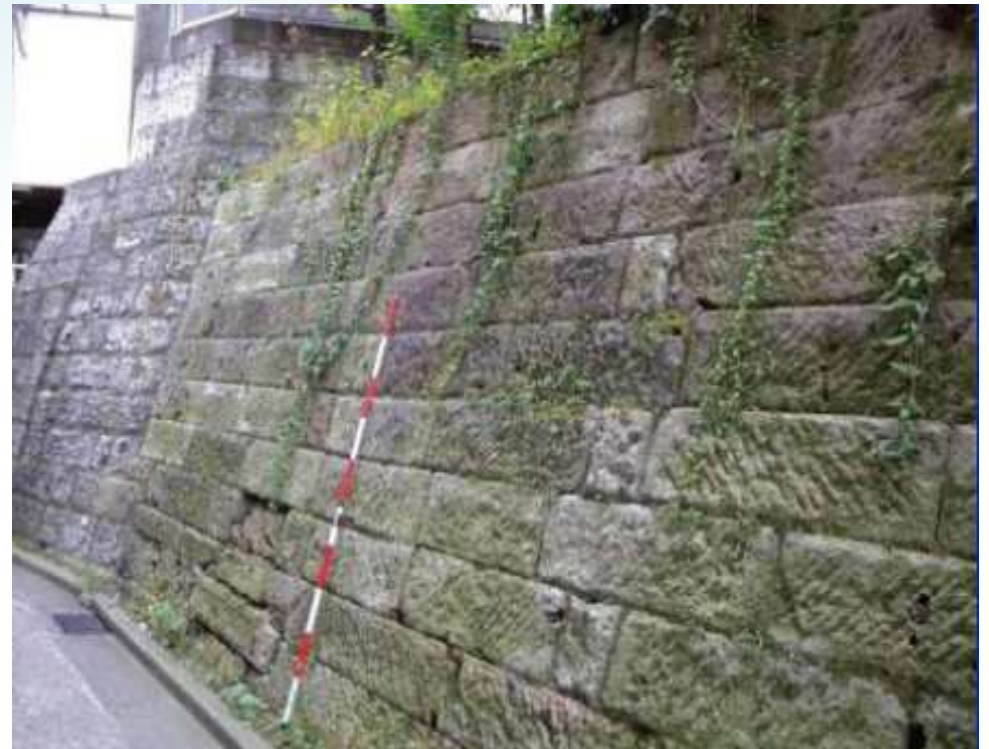
写真 大谷石積み擁壁
