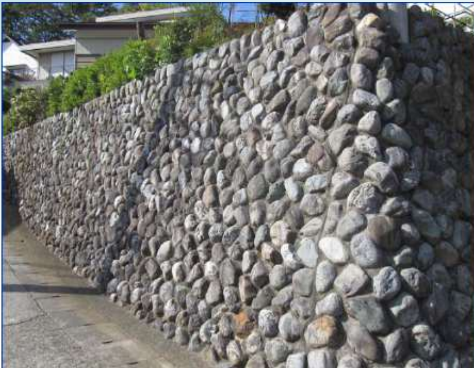
写真 空石積み擁壁
