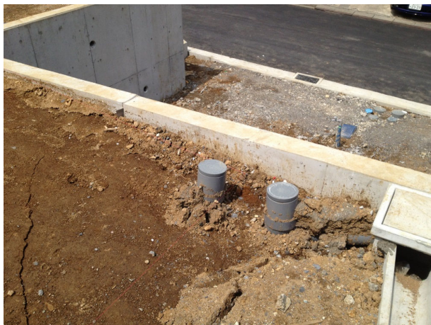
(a) 擁壁埋め戻し部
