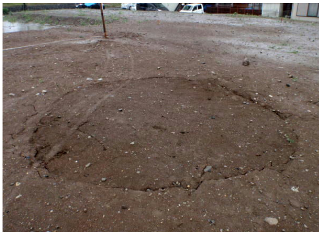
(b) 樹木抜根埋め戻し部
